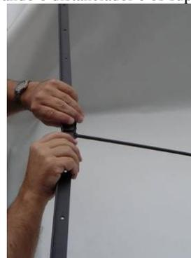
2- Coloque o Distanciador na porção mediana do quadro, unindo um dos suportes laterais com parafusos, arruelas e porcas
